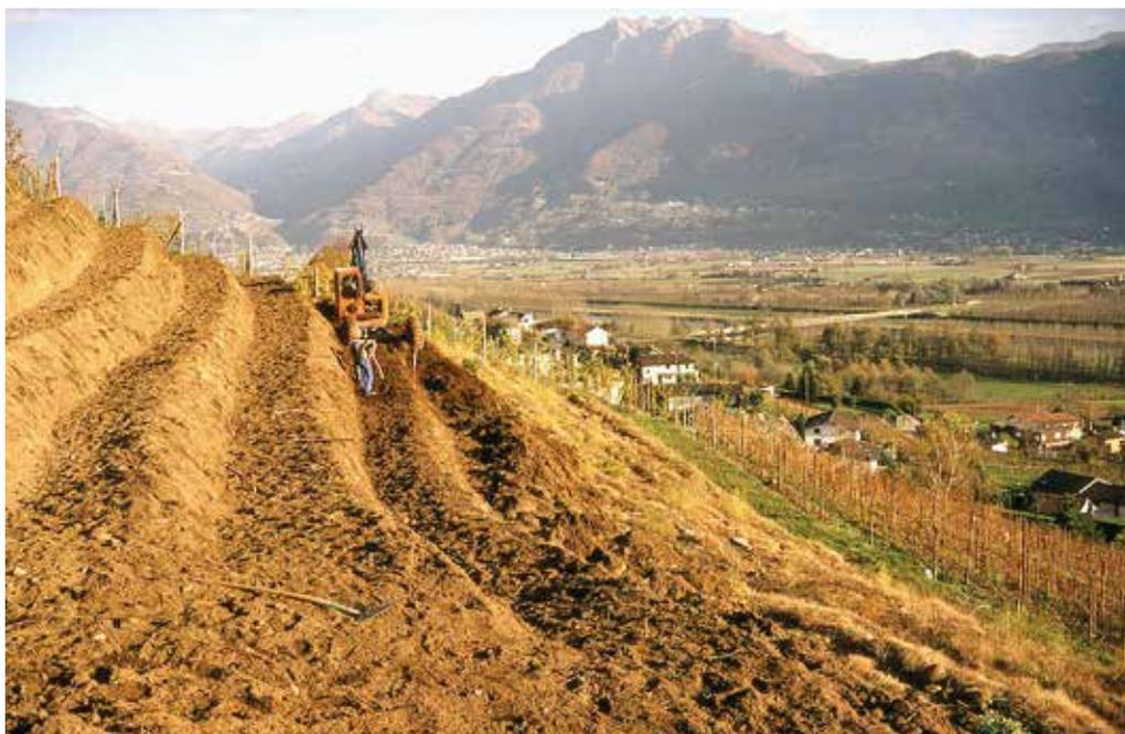
Fig. 5 – Scavatore idraulico, impiegato nella costruzione dei terrazzi e scasso del terreno (foto: Mirto Ferretti).
